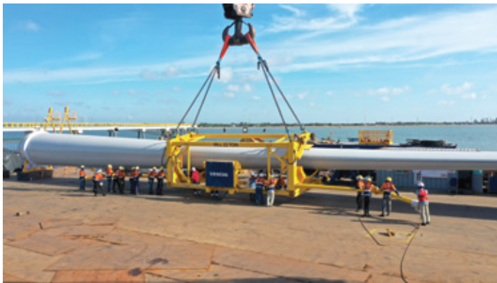
Installation of Blades Lắp đặt cánh turbine gió
