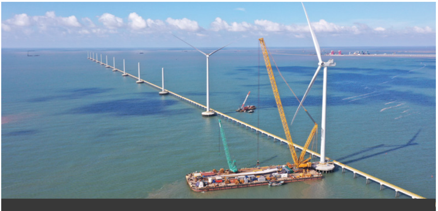
Installation of Blades Lắp đặt cánh turbine gió
