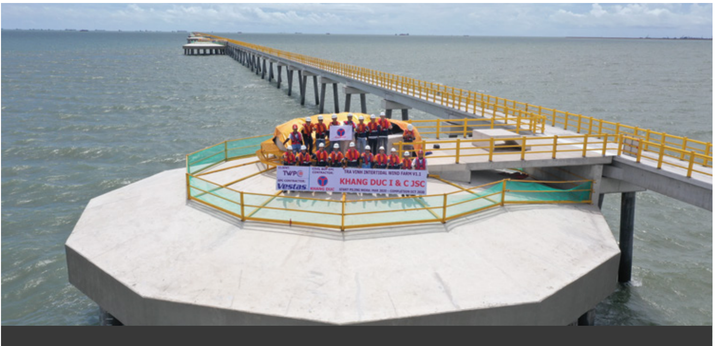
Completed WTGs foundation and link bridge Hoàn thành thi công móng và cầu dẫn
