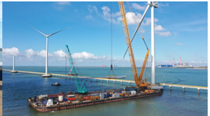
Installation of T3 Tower Lắp đặt đốt turbine T3
