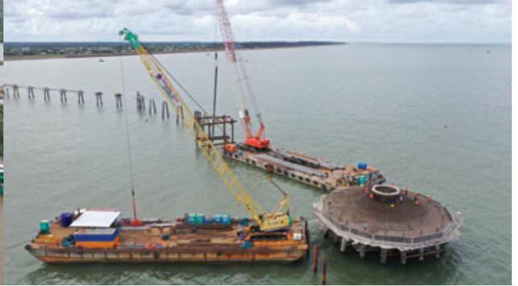
Piling and reinforcement installation. Đóng cọc và lắp đặt cốt thép
