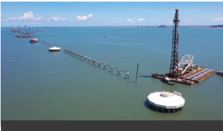
Pilling barge Tàu đóng cọc
