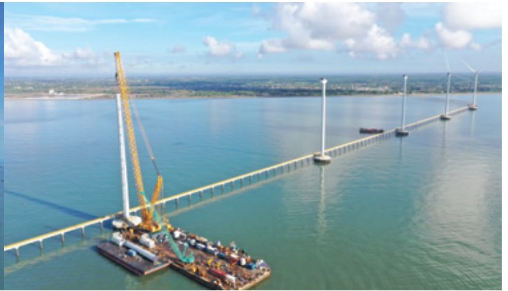
Installation of T3 Tower Lắp đặt đốt turbine T3
