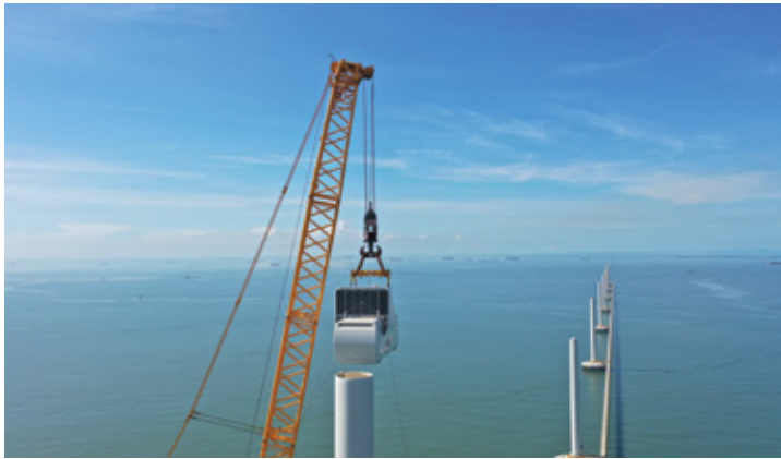
Installation of Nacelle Lắp đặt Nacelle
