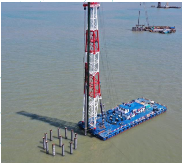
LẮP DỰNG SÀN ĐẠO VÀ ĐỔ BT MÓNG
