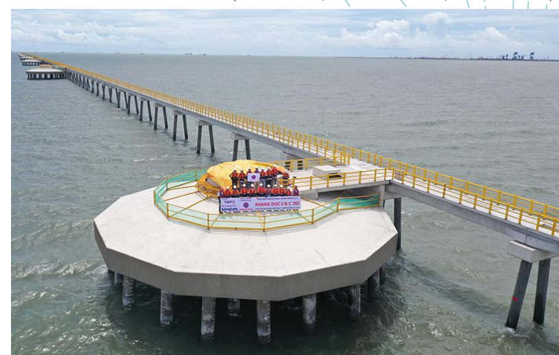
LẮP ĐẶT CÁC PHỤ TRỢ (LAN CAN, CẦU THANG, ĐÈM VÀ...)
