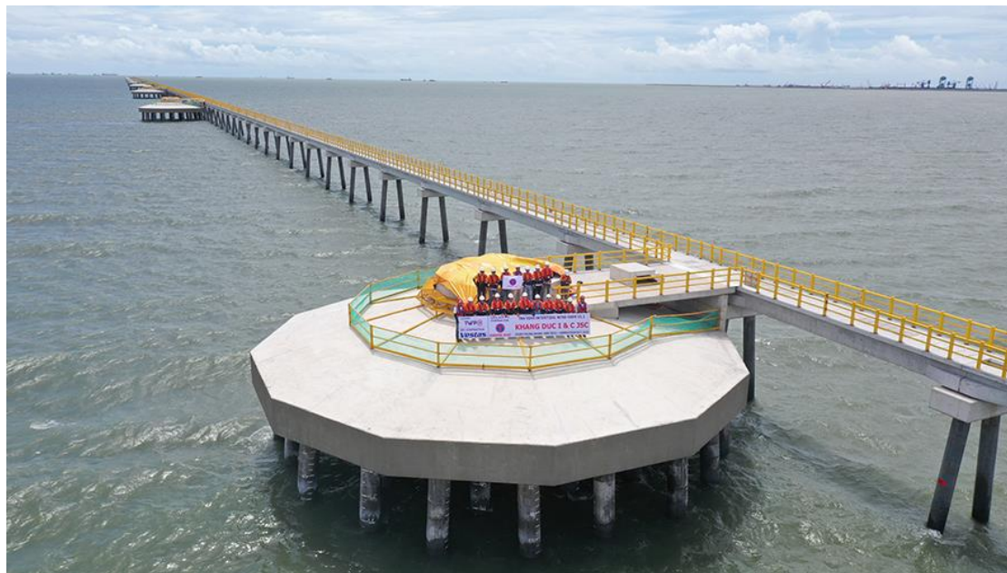
TRA VINH V1.1&V1.3 WIND FARM
