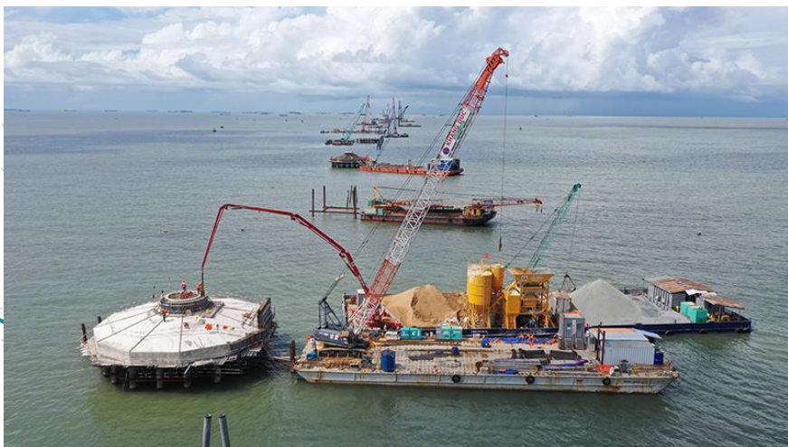
LẮP DỰNG SÀN ĐẠO VÀ ĐỔ BT MÓNG
