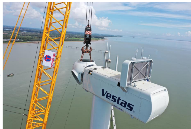
LẮP ĐẶT TRỤ GIÓ (THÂN TRỤ, BLADE, NACELLE, HUB)
